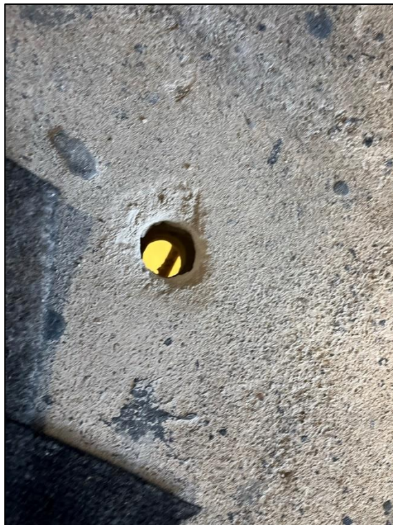
Percement du plancher au droit du sondage
